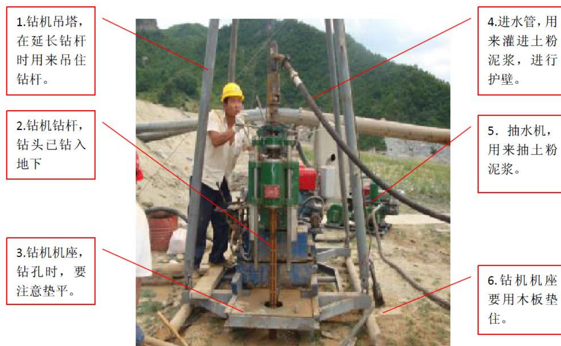
内部位移钻孔施工实景图
