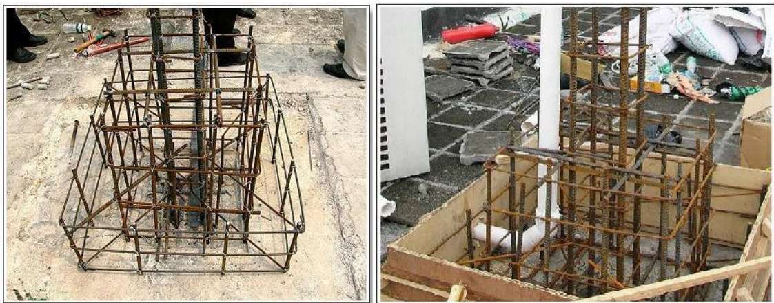
观测墩施工实景图
